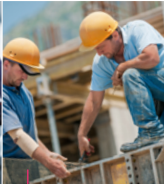
La construction (1665 h).
